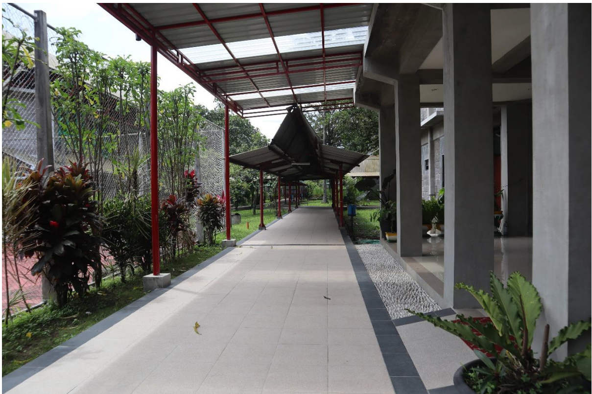
Jalan penghubung masing-masing bangunan di BBPPMPV BOE.
